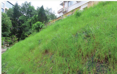
▲ 斜坡改善工程竣工後
