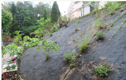
▲ 斜坡改善工程動工前
